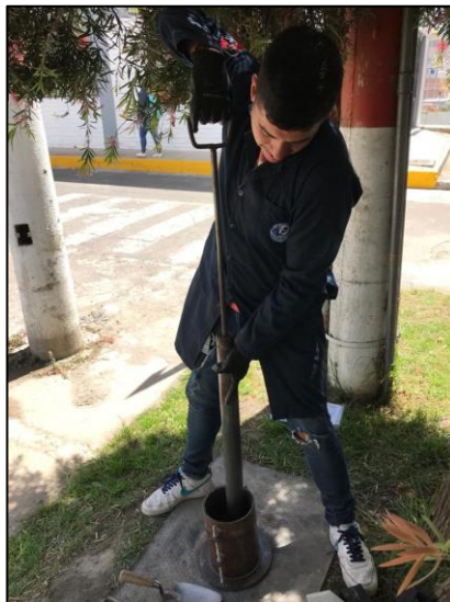
Fig 11: Compactación de 56 golpes de las 5 capas
