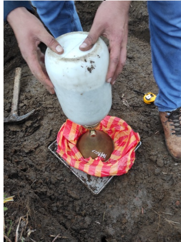
Figura 2. Ensayo de Densidad de campo
