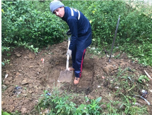
Figura 1. Excavación de pozo a cielo abierto
