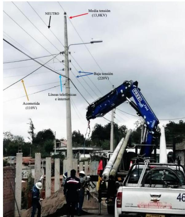
Figura 11. Disposición de las conexiones eléctricas en los postes de distribución
