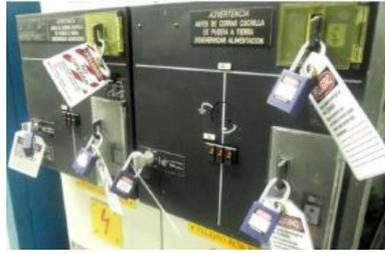
Figura 82. Etiqueta de bloqueo instalada
