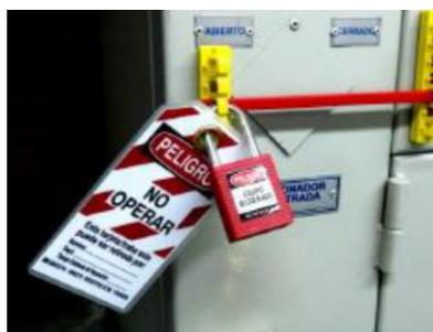
Figura 81. Equipos y seccionadores bloqueados
