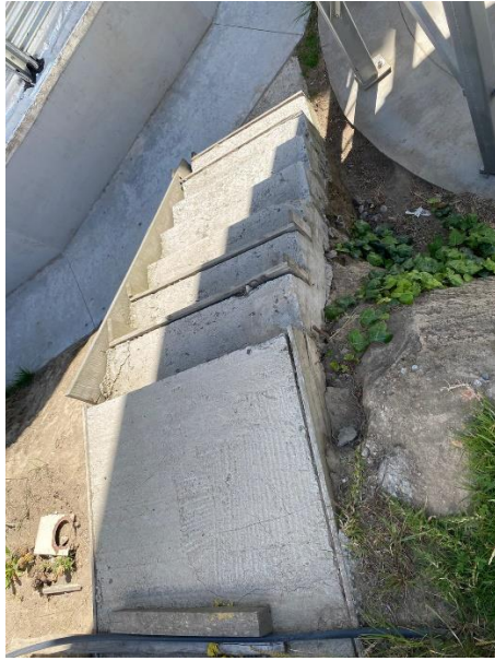
Figura 22. Mantenimiento de gradas parte externa de la planta.
