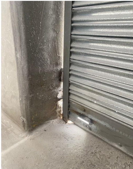
Figura 32. Huecos en lanfor junto a ensacado
