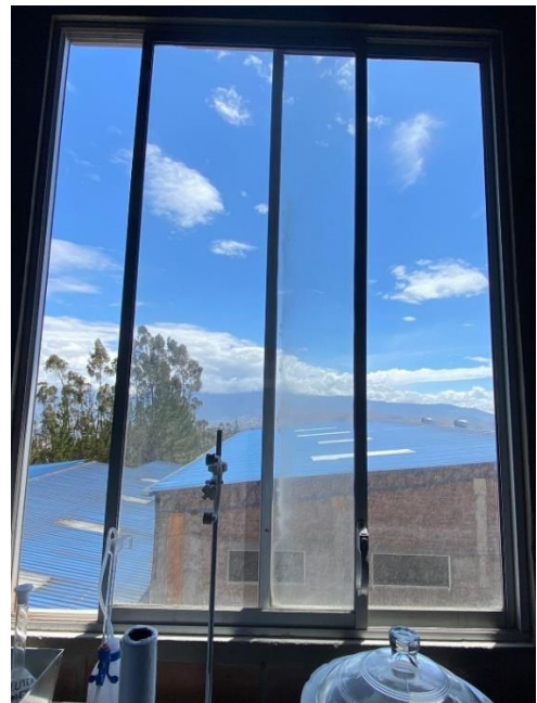
Figura 29. Falta de protección film plástica y mallas para evitar ingreso de insectos (calidad).
