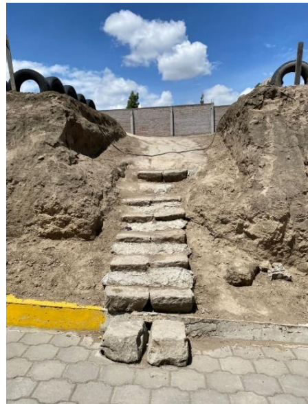
Figura 21. Mantenimiento de gradas parte externa de la planta.
