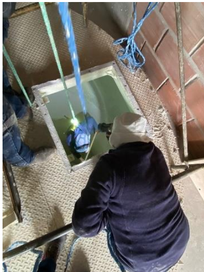
Figura 44. Limpieza de silos
