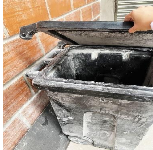
Figura 39. Basureros en mal estado y sin señaléticas
