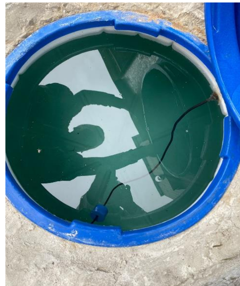
Figura 53. Limpieza de cisterna
