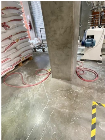
Figura 20. Falta de orden en bodega
