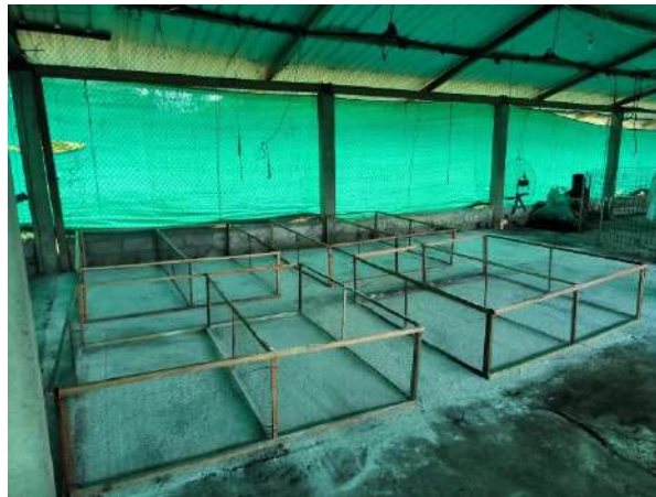
Anexo 15. Preparación de las instalaciones
