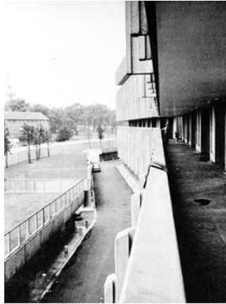
Figura 18. Calles interiores y muro acústico. Casino (2013).
