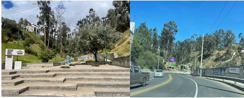
Figura 16 Estado actual del Parque Maruja Cobo García. Foto de autor 2023
