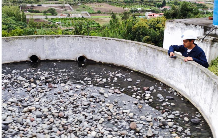
Figura 48. Dimensionamiento de la unidad FFAF con distanciómetro laser. Fuente: Autor
