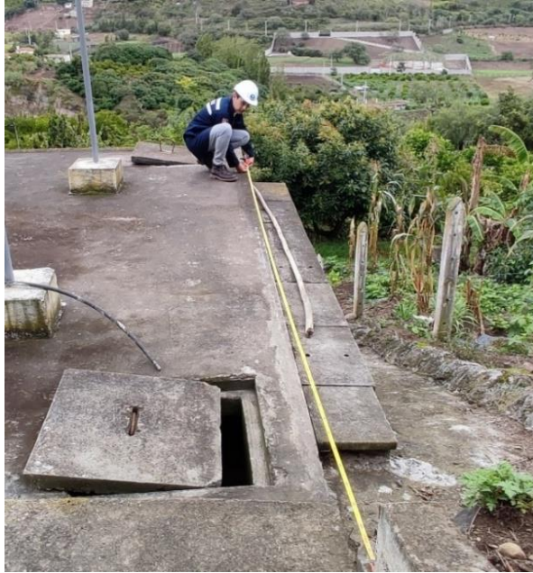
Figura 2. Dimensionamiento de los componentes de la PTAR.
