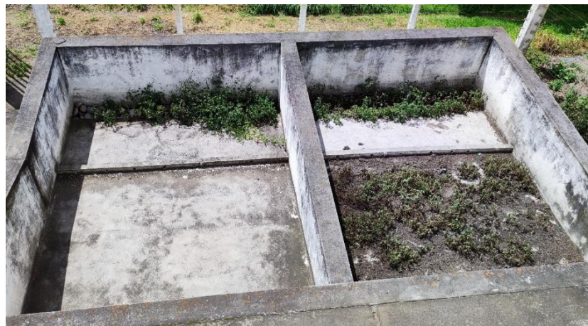
Figura 45. Falta de mantenimiento en el tanque hipo clorador. Fuente: Autor
