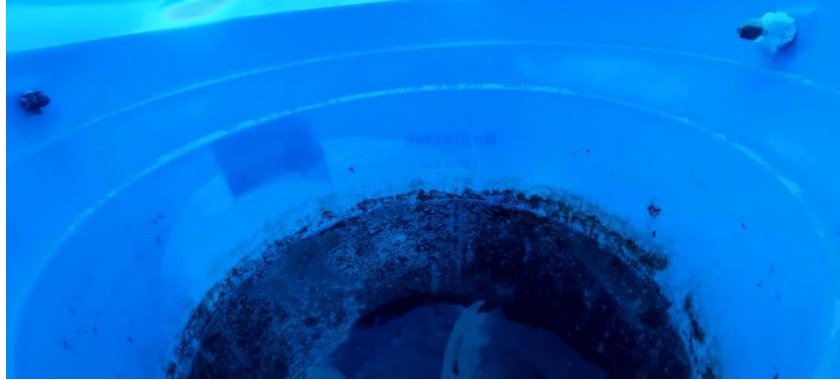
Figura 45. Falta de mantenimiento en el tanque hipo clorador. Fuente: Autor
