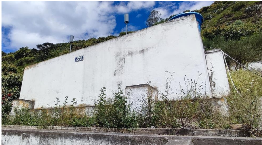
Figura 55. Vista frontal del tanque séptico se denota la maleza a su alrededor. Fuente: Autor
