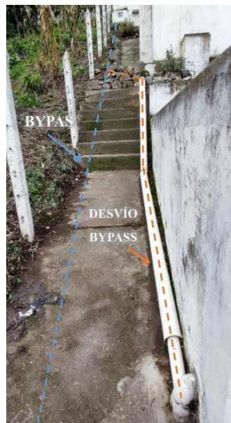
Figura 8. Solución de la administración de la PTAR a la obstrucción del bypass.
