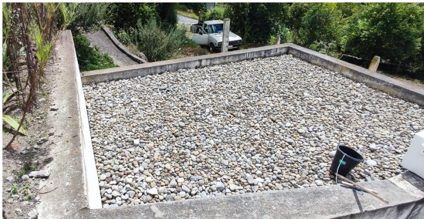
Figura 57. Vista lateral del filtro descendente. Fuente: Autor
