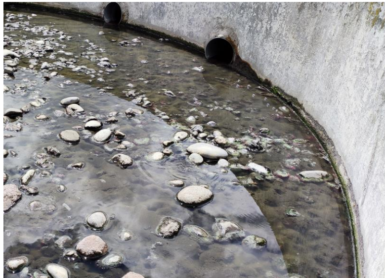
Figura 13. Material fino sobre el material de soporte en el filtro biológico. Fuente: Autor
