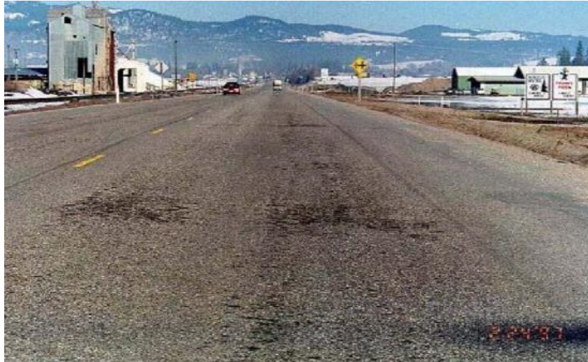
Gráfico 37: Meteorización/Desprendimiento de Agregados.
