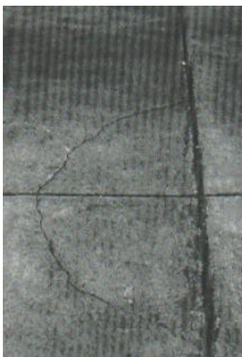
Gráfico 52: Agrietamiento de esquina severidad baja. Fuente: Pavement Condition Index (PCI) Para Pavimentos Asfálticos Y De Concreto En Carreteras - Vásquez Luis - 2002
