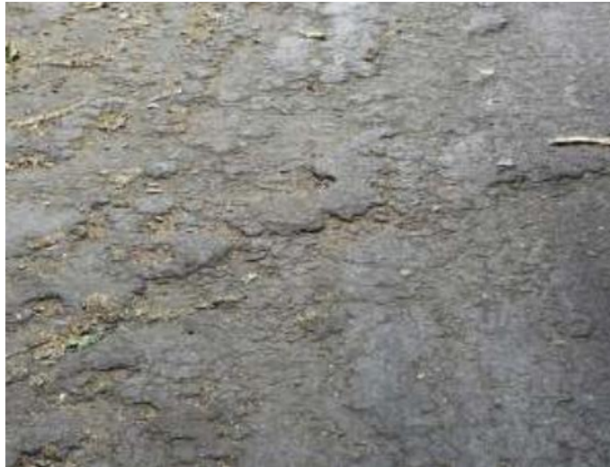
Gráfico 12: Abultamientos y Hundimientos.
