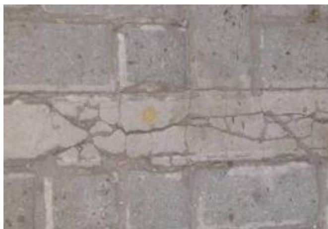
Gráfico 60: Fracturamiento de Confinamientos Internos.
