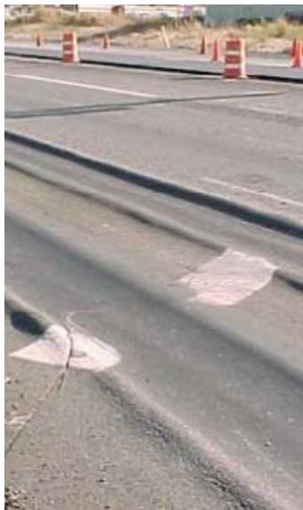
Gráfico 31: Ahuellamiento severidad media.
