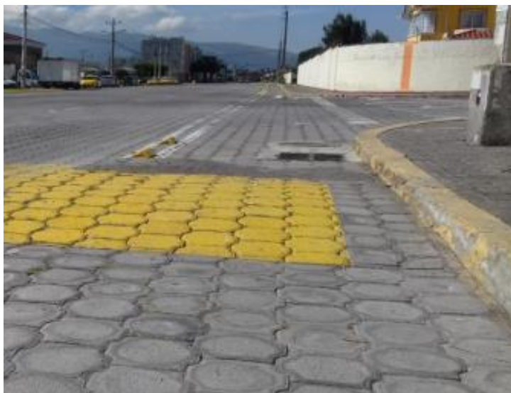
Gráfico 58: Desplazamiento de Borde.
