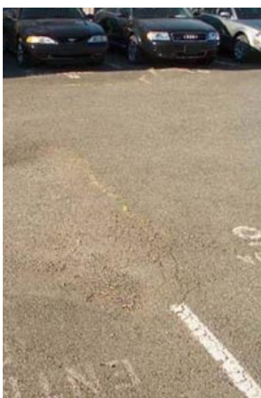
Gráfico 14: Abultamiento y hundimiento severidad media.
