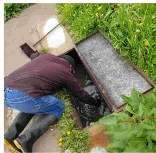
Mantenimiento del reactor UASB
