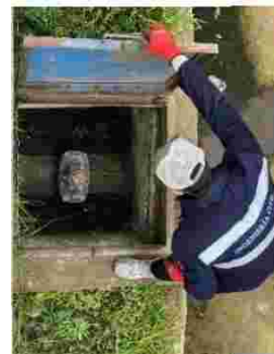
Revisión de válvulas de compuerta
