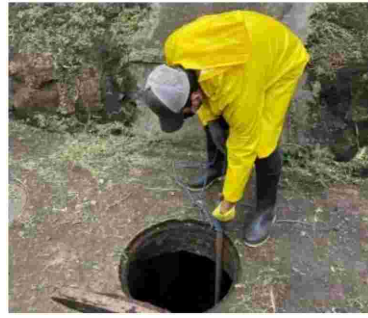
Medición de caudales de salida en la PTAR
