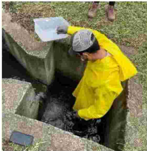
Figura 4. Medición de caudales de entrada de la PTAR
