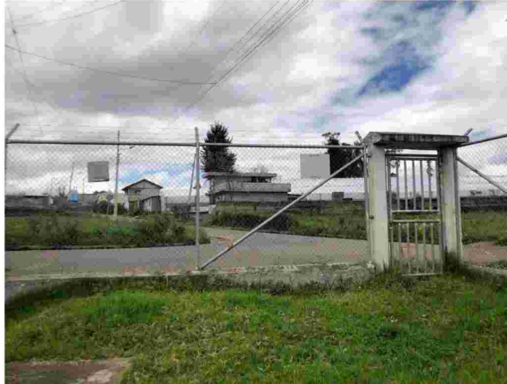
Figura 31. Cerramiento de la PTAR
