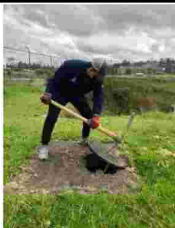
Apertura de pozos de revisión
