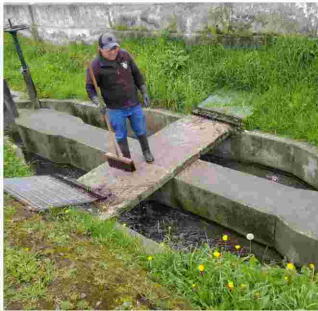
Mantenimiento del desarenador
