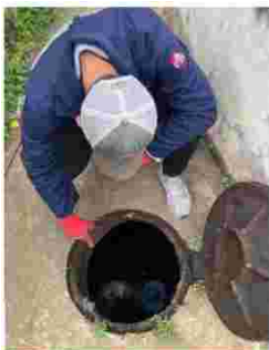
Limpieza de pozo de revisión
