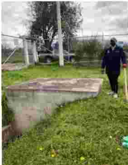
Pozo de aliviadero en la PTAR
