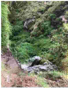
Basura dentro de la quebrada de descarga
