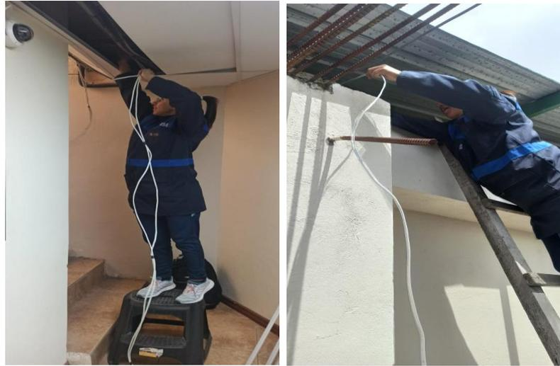
**Figura 68.** Tendido de cables
