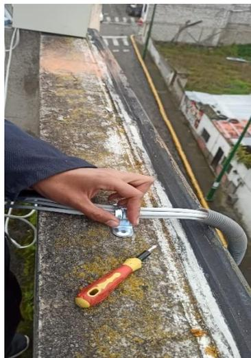
**Figura 69.** Colocación de abrazaderas
