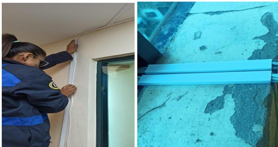
**Figura 70.** Instalación de canaletas
