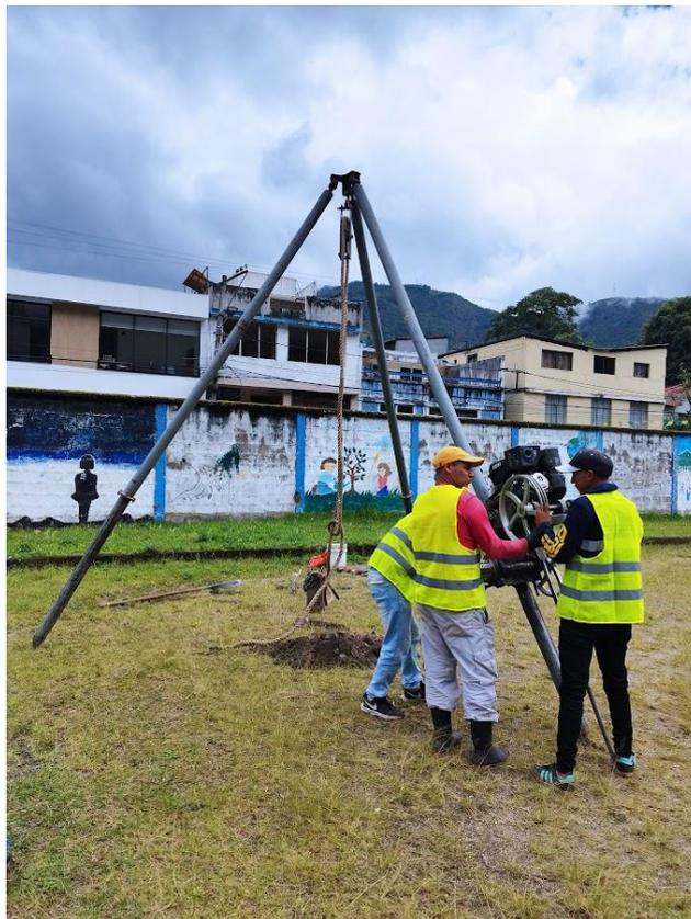
Fotografía 1. Instalación del equipo SPT
