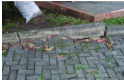
Figura 33. Fracturamiento de Confinamientos Externos (m2)
