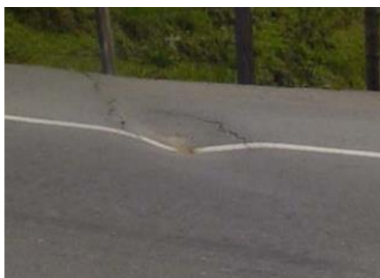
Figura 8. Hundimientos (m2)
