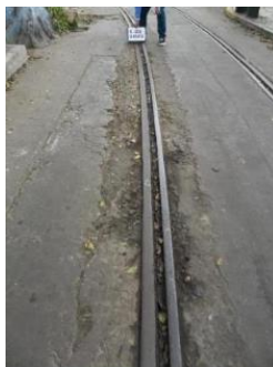
Figura 19. Cruce de Vía Férrea (m2)
