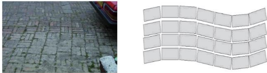
Figura 31. Desplazamiento de Juntas (m2)
