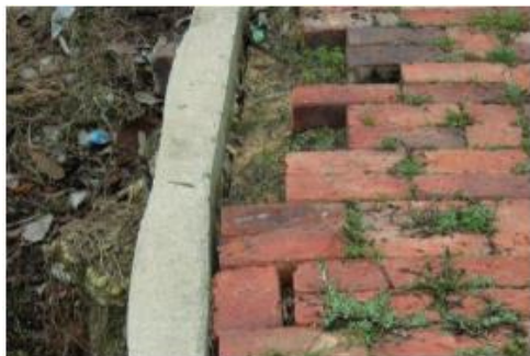
Figura 30. Desplazamiento de Borde (m2)
