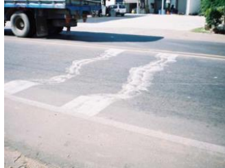
Figura 20. Ahuellamiento (m2)
