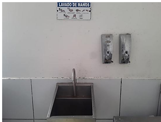
Figura 12: Implementación de un lavamanos.
