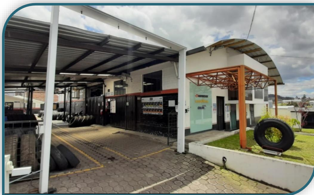
Fig. 13. Empresa CAUCHOSIERRA S.A. (Planta principal)
