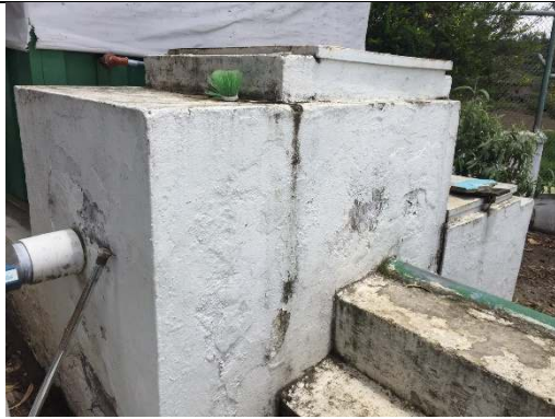
Fotografía 15: Tanque de llegada y mezcla de agua natural.
