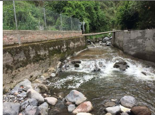
Fotografía 18: Obra de captación de vertientes aledañas al Río Pachanlica.
