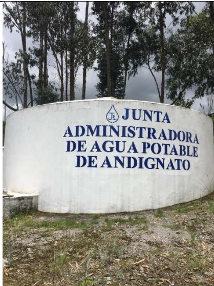
Fotografía 13: Tanque principal de almacenamiento del agua desinfectada.
