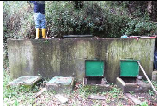
Fotografía 4: Levantamiento de información del tanque desarenador.
