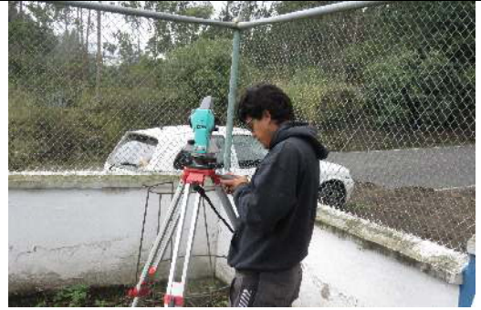
Fotografía 2: Levantamiento de información de tanque de almacenamiento y Caseta de cloración.
