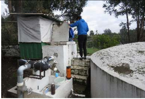
Fotografía 1: Revisión de agua después de desinfección.
