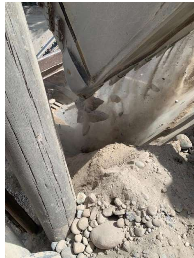
Colocando el hormigón reciclado en la trituradora
