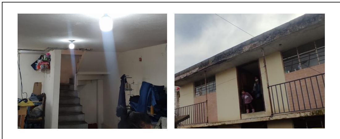
Fotografía 3. Escaleras y barandillas de los centros de trabajo
