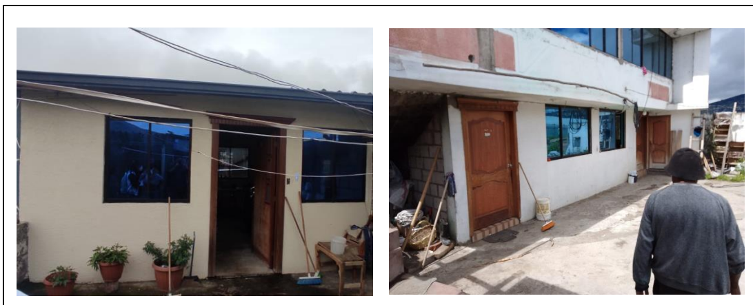
Fotografía 1. Seguridad estructural de las maquilas
