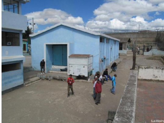
4.5.6) infraestructura del CRSA
