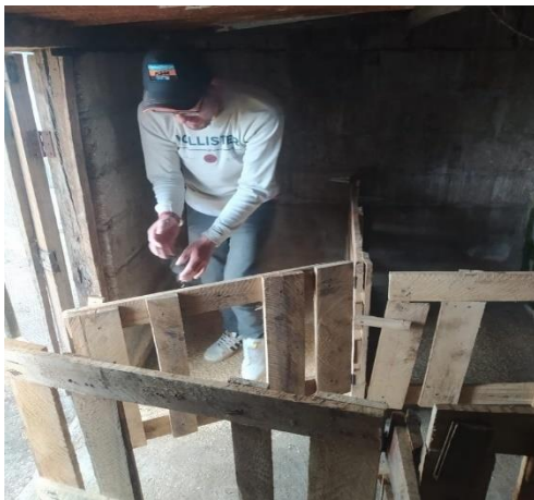
Colocación de la cama.
