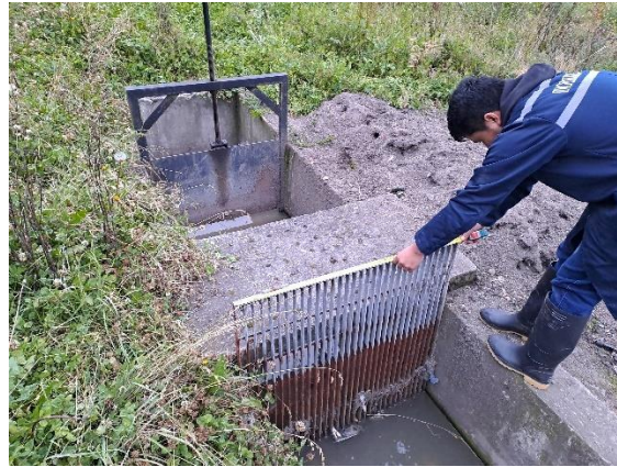
Figura 2. Medición de los componentes unitarios de la PTAR.
