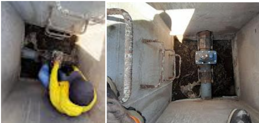
Fig. 61 Inspección del estado actual de las válvulas. Fuente: Vinicio Ortega
