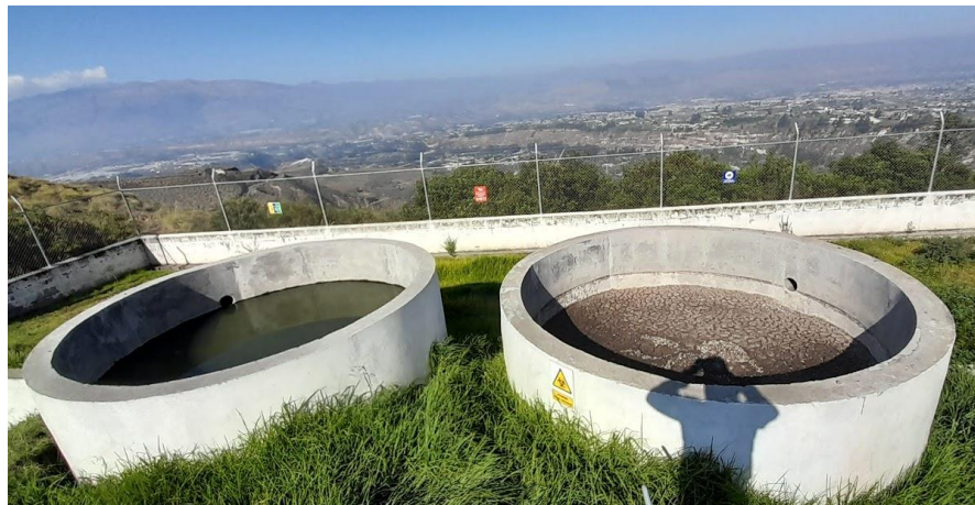
Fig. 40 Limpieza y Mantenimiento del FAFA.
