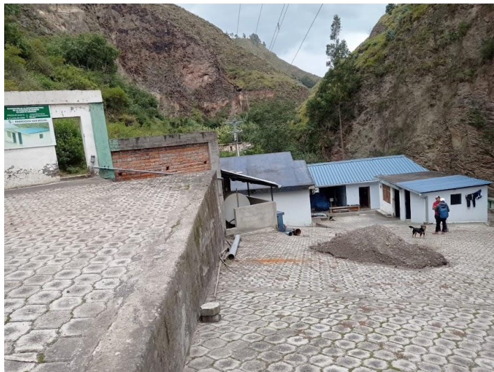
Fig. 12 Reconocimiento de la estación de bombeo de agua El Carrizal.
