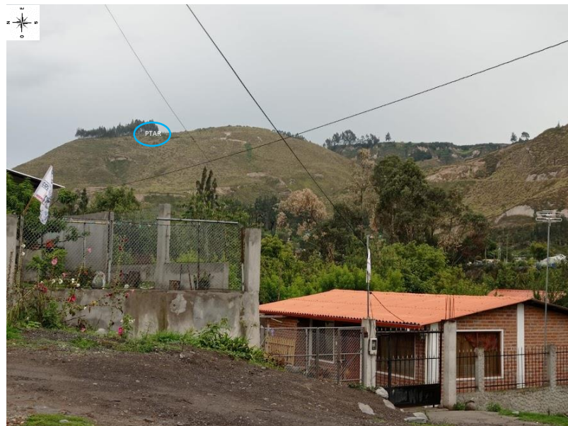
Fig. 15 Vista desde la comunidad Yanayacu en dirección a la PTAR.
