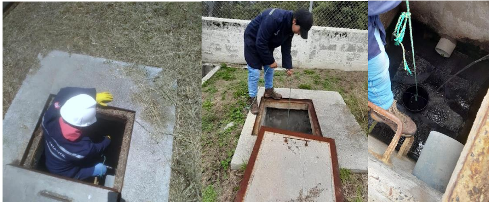
Fig. 42 Vista de la superficie y fondo del pozo de descarga.
