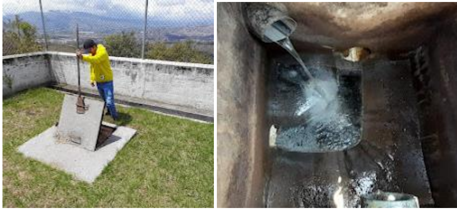
Fig. 60 Inspección de las cajas de revisión. Fuente: Vinicio Ortega.
