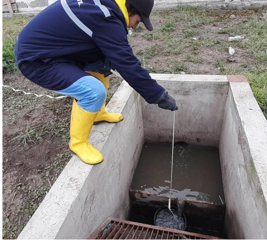
Fig. 21 Medición del caudal de ingreso a la PTAR.
