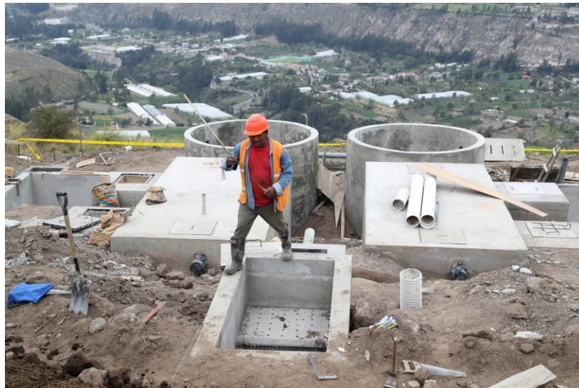
Fig. 9 Construcción de la PTAR del sector Cardo Santo.
