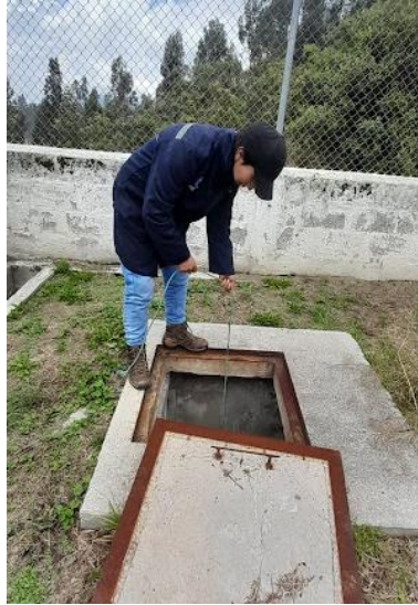
Fig. 23 Medición del caudal de salida de la PTAR.
