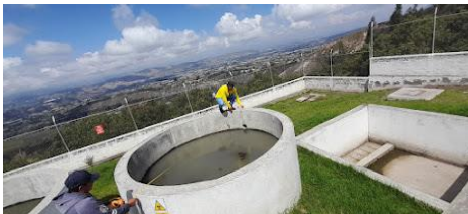
Fig. 62 Medición del FAVA de la PTAR. Fuente: Vinicio Ortega.
