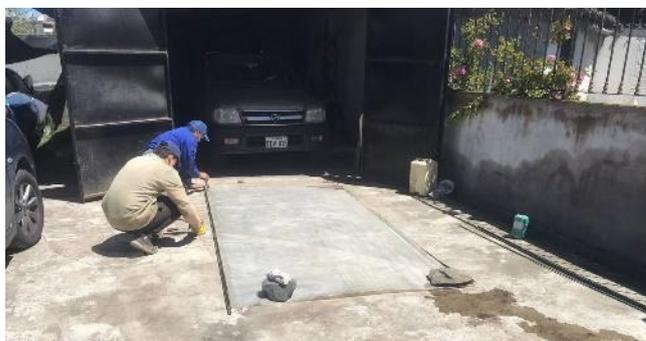
**Figura 123.** Proceso de fijación del plástico al tubo.
