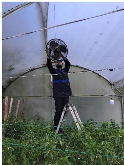
**Figura 134.** *Instalación de ventiladores*
