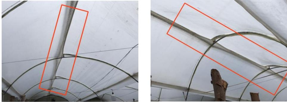
**Figura 22.** Aberturas de ventilación en la parte superior del invernadero
