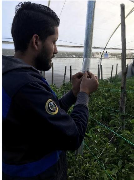
**Figura 132.** *Instalación del sensor de humedad y temperatura de ambiente (DTH11)*
