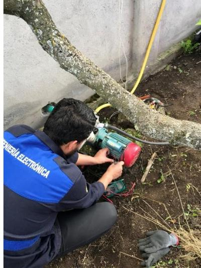
*Figura 135. Ajuste de conexiones en la bomba de agua*
