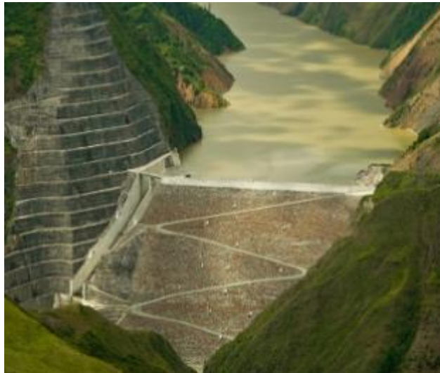
Ilustración 12 Embalse de la planta generadora Mazar [35]
