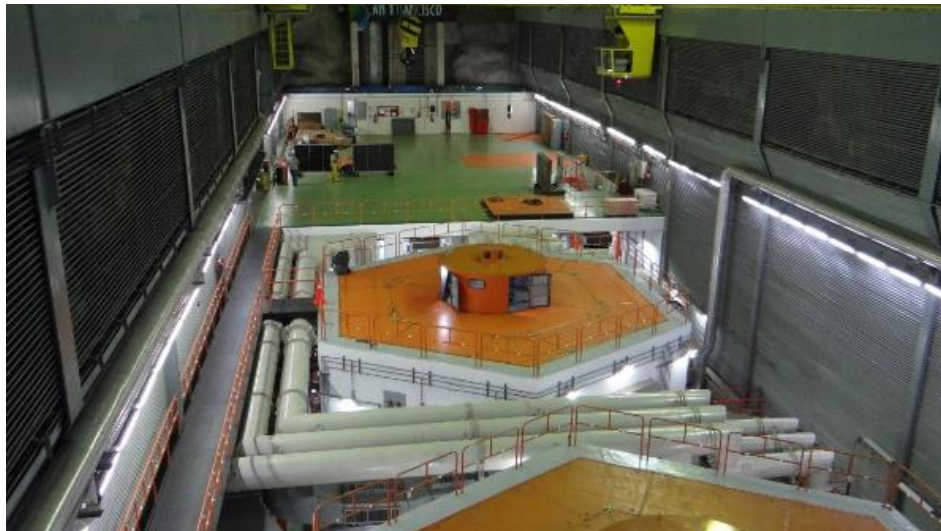
Ilustración 10 Casa de máquinas de la Central San Francisco [35]
