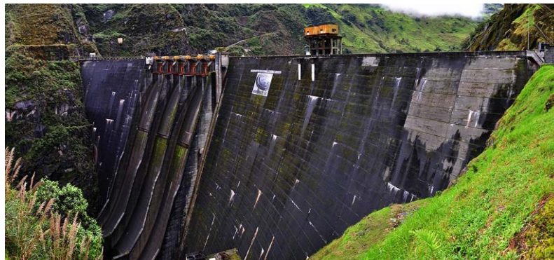
Ilustración 14 Represa Daniel Palacios de la Central Hidroeléctrica Molino [35]
