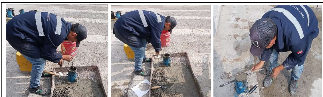
Fotografía 28: Toma de muestra de hormigón con fibras de caucho al 5% en cilindros.
