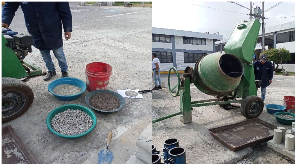
Fotografía 21: Preparación de equipos y materiales para la elaboración del hormigón simple (concretera, fuentes, bailejo, bandejas, varilla de compactación, martillo de goma, cantidades de los agregados, cemento y agua).
