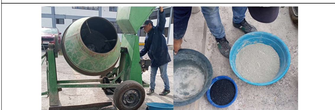
Fotografía 29: Preparación de equipos y materiales para la elaboración del hormigón con fibras de caucho al 10% (concretera, fuentes, bailejo, bandejas, varilla de compactación, martillo de goma, cantidades de los agregados, cemento, fibras de caucho y agua).
