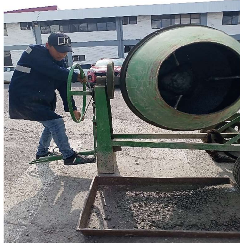
Fotografía 23: Obtención de la mezcla de hormigón simple.
