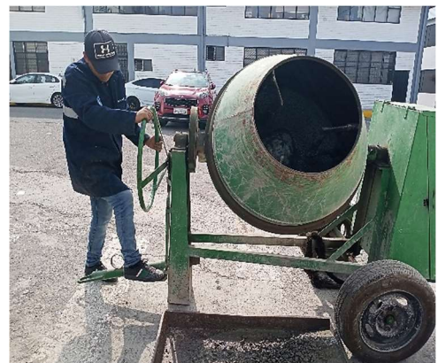
Fotografía 27: Obtención de la mezcla de hormigón con fibras de caucho al 5%.
