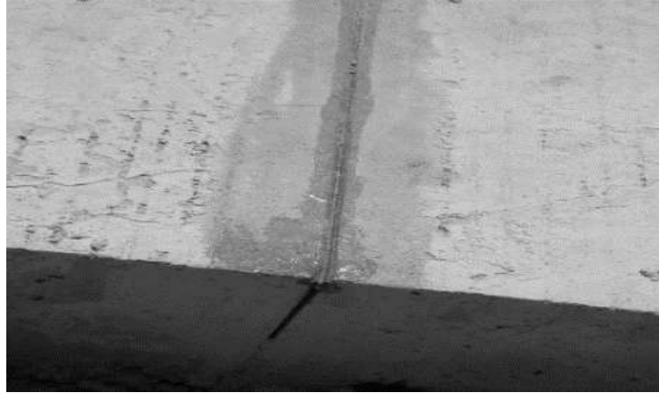
Gráfica 32: Falla del Pavimento Rígido – Falla Sellada
