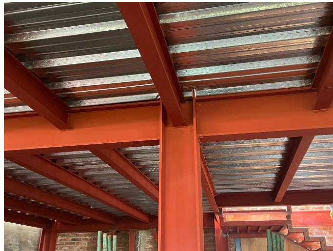
Figura 19. Vista de una conexión viga columna
