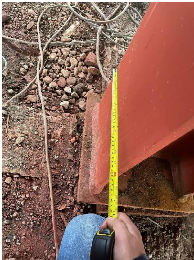
Figura 25. Corroboración de dimensiones de la columna HEB 300
