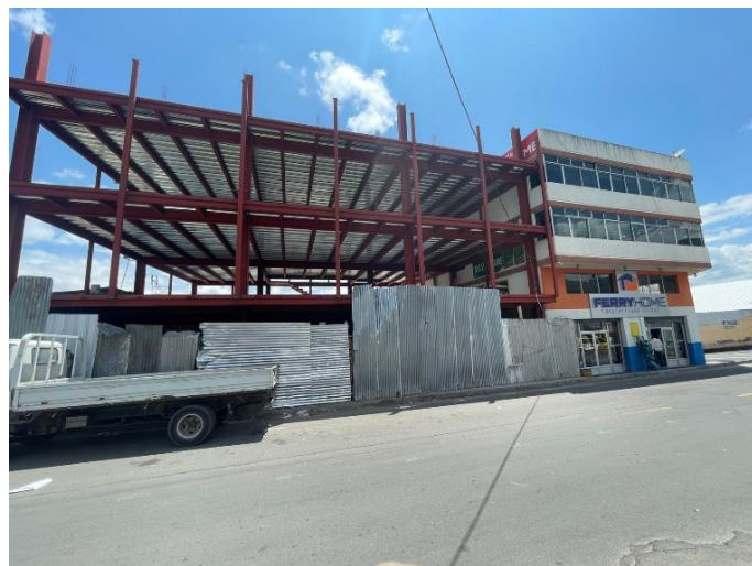
Figura 20. Vista frontal de la estructura a analizar
