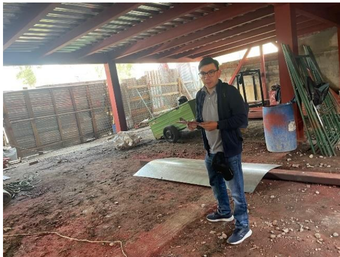
Figura 22. Inspección in situ por parte del investigador
