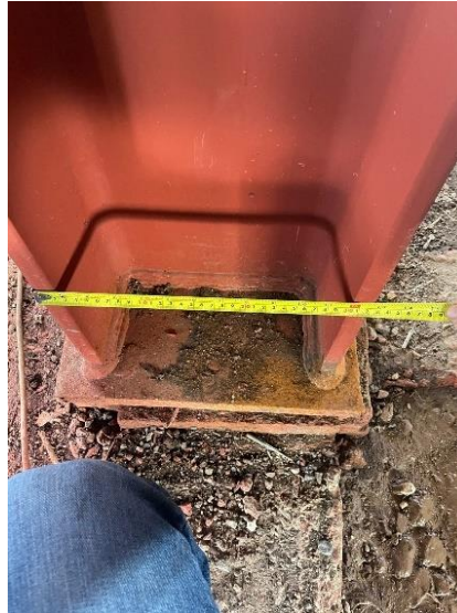
Figura 26. Corroboración de dimensiones de la columna HEB 320
