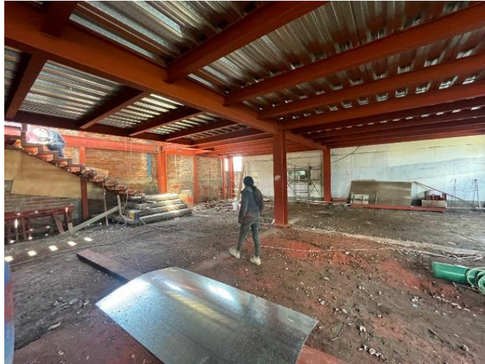
Figura 21. Vista interior de la estructura a analizar
