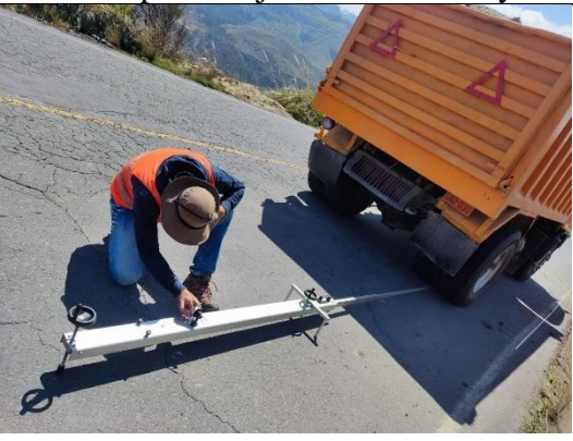
Fotografía 11.- Colocación de la viga Benkelman para la ejecución del ensayo
