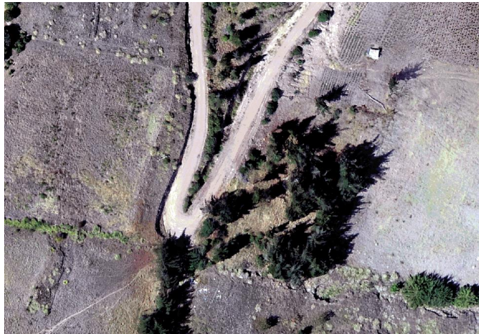
Figura 3. Curva con radio mínimo (Zona peligrosa)
