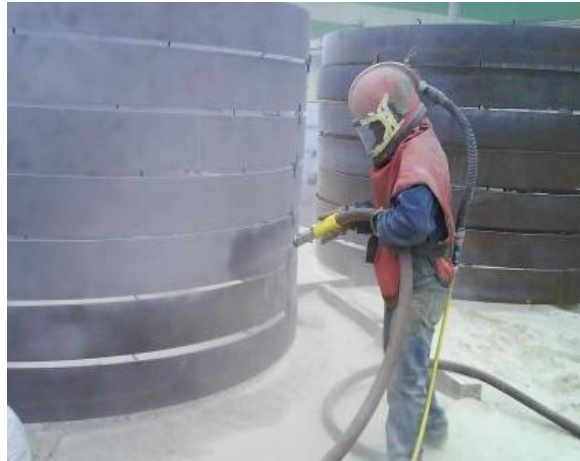
Figura 6.1 Limpieza abrasiva seca
