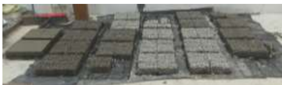
Fig. 83 Construcción de Adoquines
