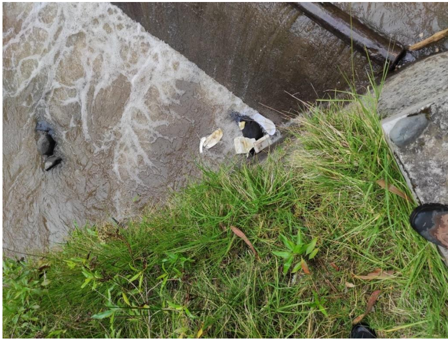
Fotografía N°4. Obstáculos de gran tamaño que obstruyen la obra de captación.
