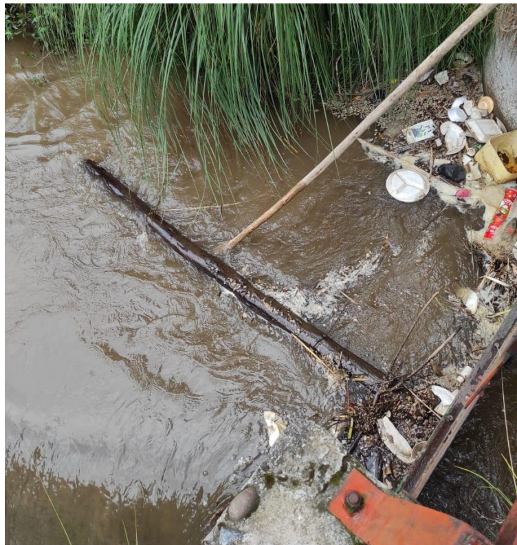
Fotografía N°4. Obstáculos de gran tamaño que obstruyen la obra de captación.
