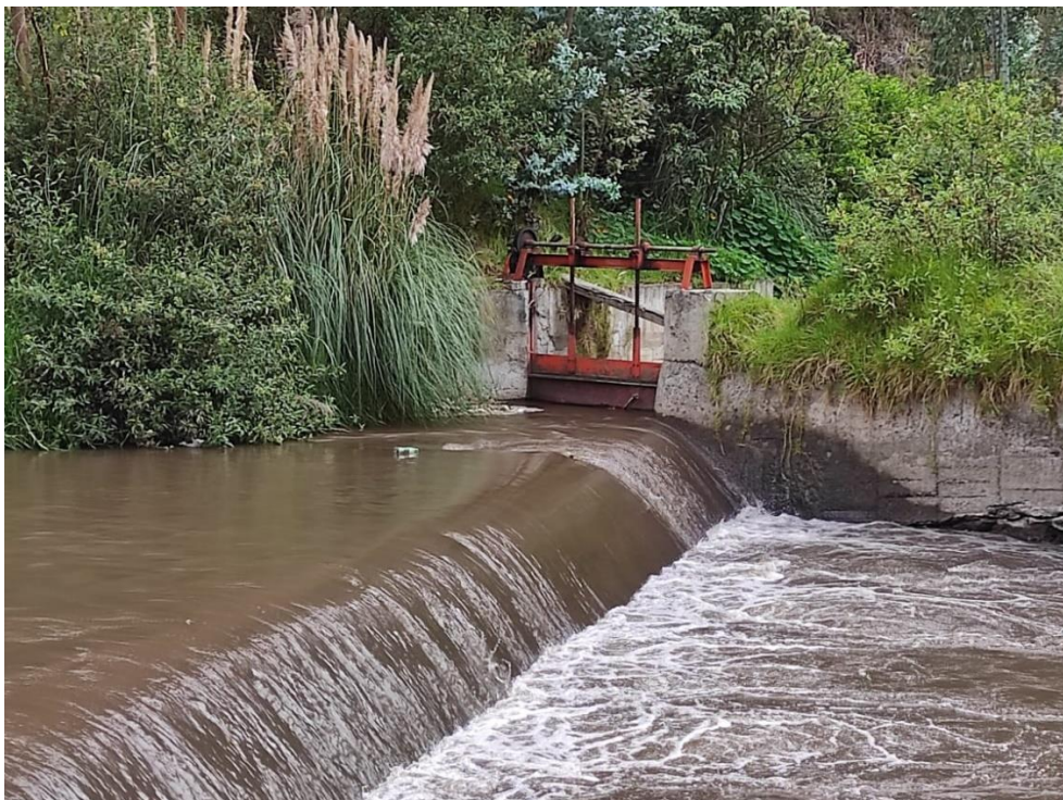
Fotografía N°14. Acumulación de vegetación en la entrada de la bocatoma.
