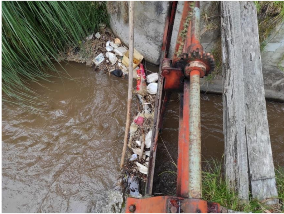
Figura 26. Estado de la bocatoma.
