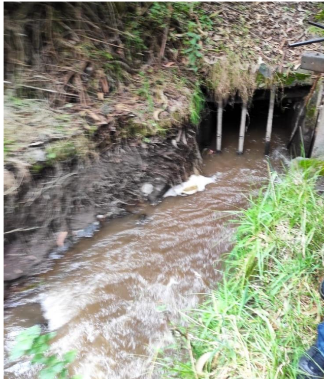
Fotografía N°10. Rejilla en mal estado, acumulación de vegetación.
