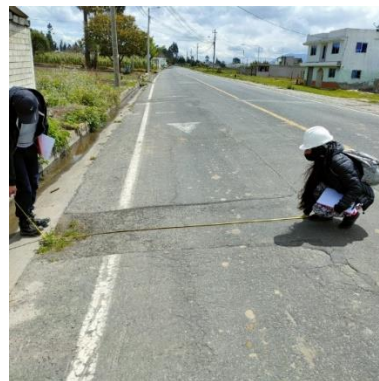
FOTOGRAFÍA 4: Parchado de la vía – Abscisa 10+450
