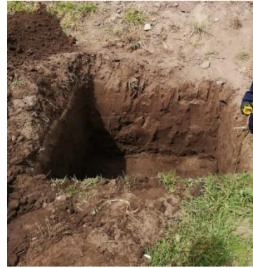
FOTOGRAFÍA 2: Retiro de capa vegetal de la zona para la toma de muestras.
