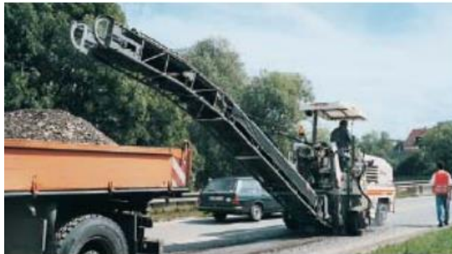
Figura 14. Texturizado superficial de la capa de rodamiento
