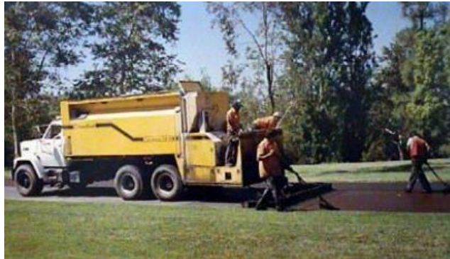
Figura 17. Restauración de un pavimento con lechada asfáltica
