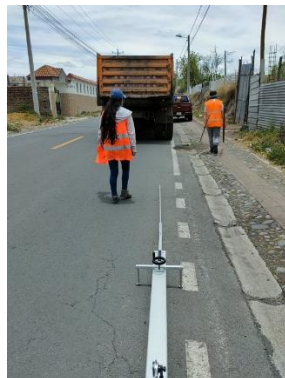
FOTOGRAFÍA 5: Ejecución del ensayo.
