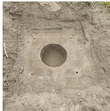
FOTOGRAFÍA 6: Final del ensayo de densidad de campo.
