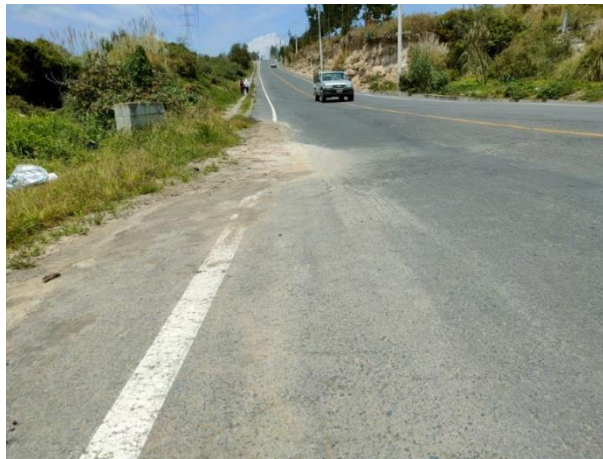
Figura 36. Depresiones en la abscisa km 8+080 - 8+100 – Unidad de prueba A1
