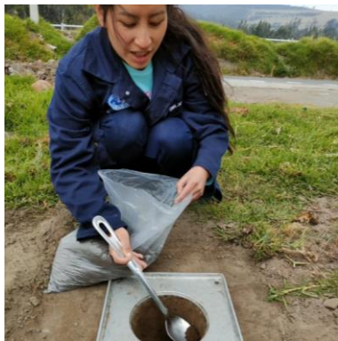
FOTOGRAFÍA 5: Extracción de muestra para ensayo de cono y arena.
