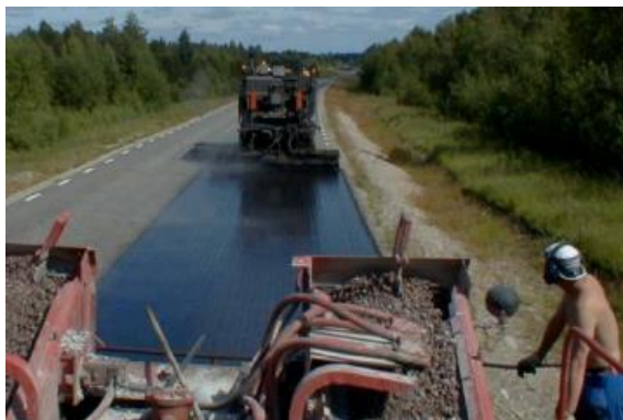
Figura 18. Restauración de un pavimento asfáltico con Tratamiento superficial
