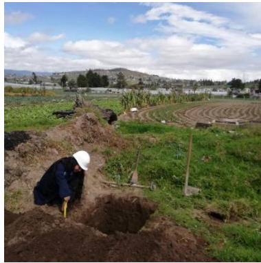
FOTOGRAFÍA 3: Excavación completa de la calicata y toma de muestras.
