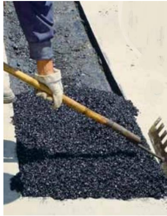
Figura 15. Bacheo de un pavimento asfáltico
