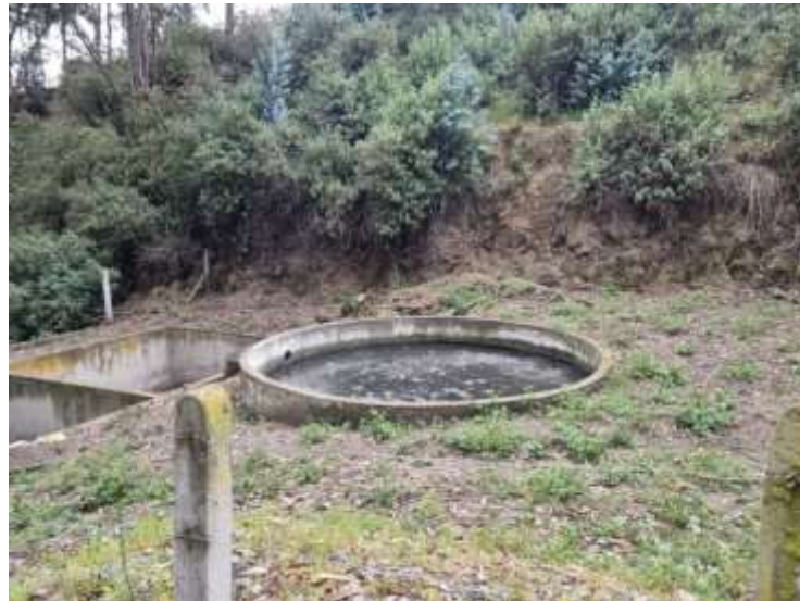
Ilustración 25. Filtro biológico de la PTAR El Rosal.
