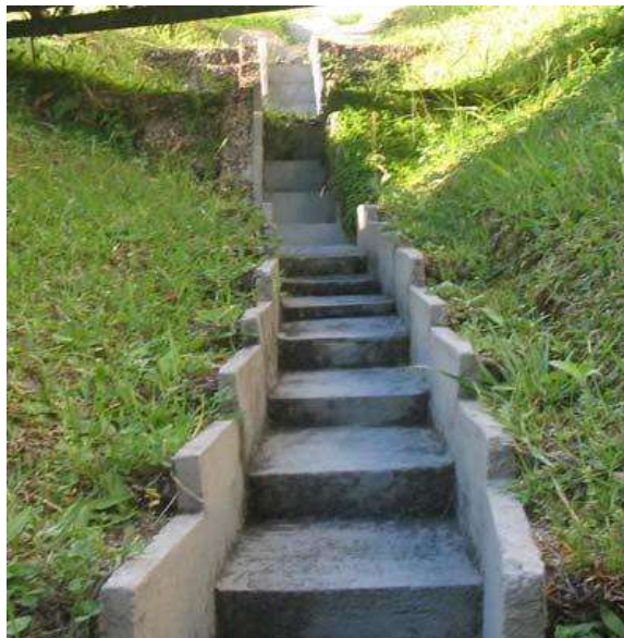
Ilustraci3n 6. Rpidas escalonadas para disipaci3n de energa.
