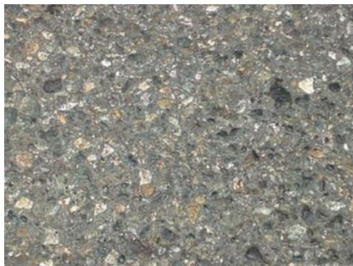
Figura 20. Pulimiento de agregados
