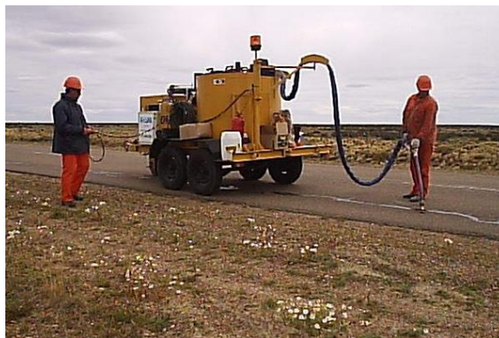
Figura 4. Sello de grietas y fisuras
