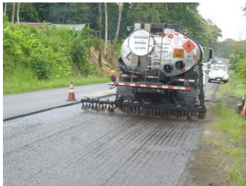
Figura 7. Riego de imprimación reforzada
