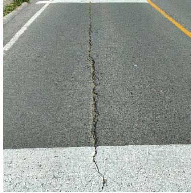
Figura 18. Grieta longitudinal
