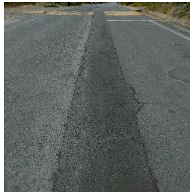
Figura 19. Parcheo y acometidas de servicios públicos
