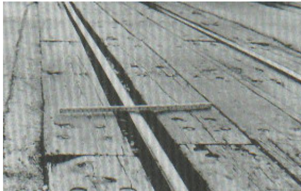
Figura 22. Cruce de vía férrea
