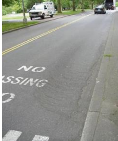
Figura 25. Grietas parabólicas
