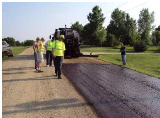
Figura 3. Aplicación de riego de imprimación
