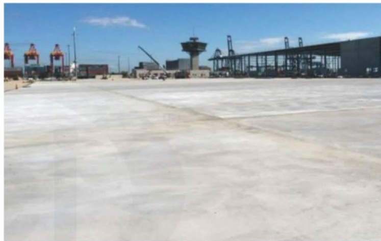
Figura 7. Piso sin juntas de 50000 m 2
