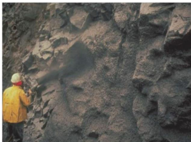
Figura 11. Estabilización de rocas con hormigón reforzado con fibras de acero
