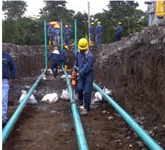
Foto 6.28. Inspección de discontinuidades en tubería instalada.
