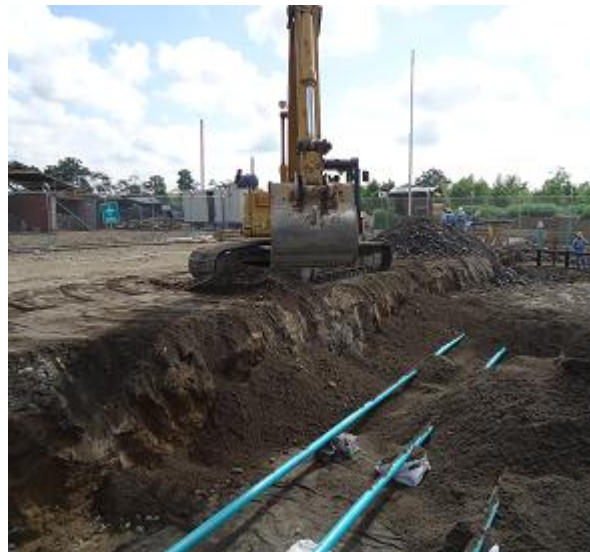
Foto 6.32. Colocación de arena sobre tubería instalada.
