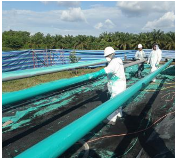
Foto 6.22. Aplicación de recubrimiento con brocha.
