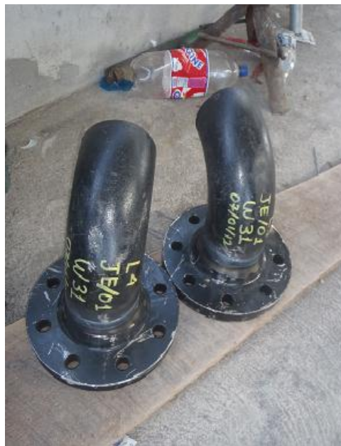
Foto 6.9. Identificación de juntas soldadas.
