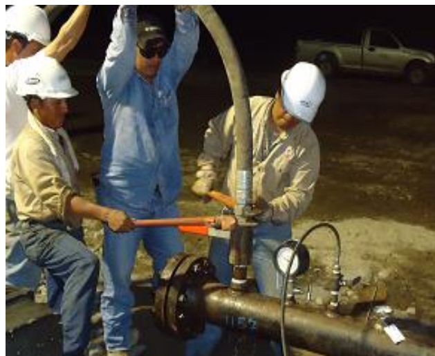
Foto 6.39. Llenado de líneas desde cabezal de pruebas.
