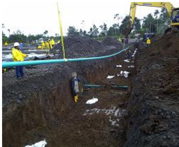
Foto 6.30. Tendido de líneas con maquinaria pesada.
