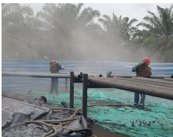
Foto 6.13. Granallado en tubería.
