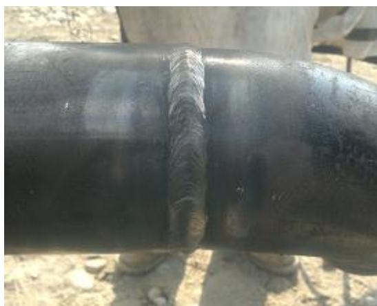
Foto 6.8. Presentación de una junta soldada.
