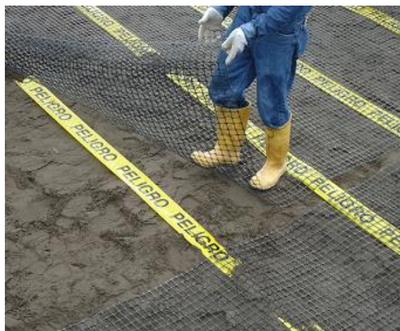
Foto 6.34. Colocación de Tensar y cinta de peligro.
