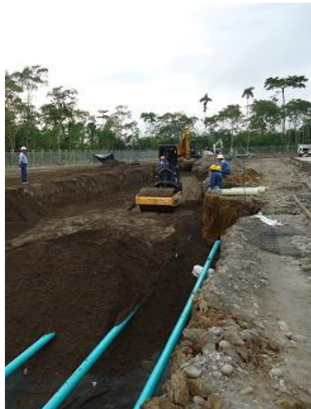
Foto 6.33. Compactación de arena.
