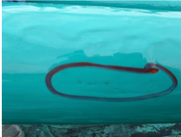
Foto 6.25. Detección de “Hollidays” en recubrimiento.
