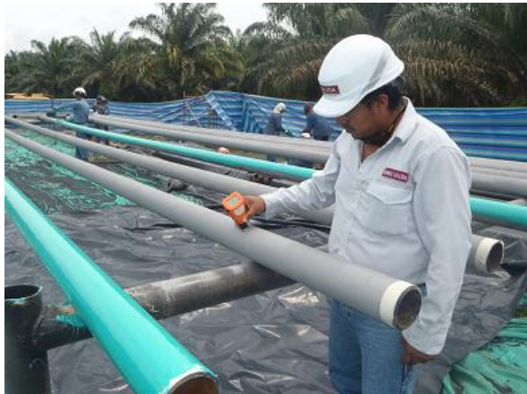
Foto 6.16. Verificación del perfil de anclaje.
