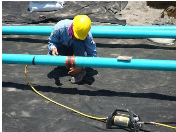
Foto 6.10. Colocación de placas radiográficas.
