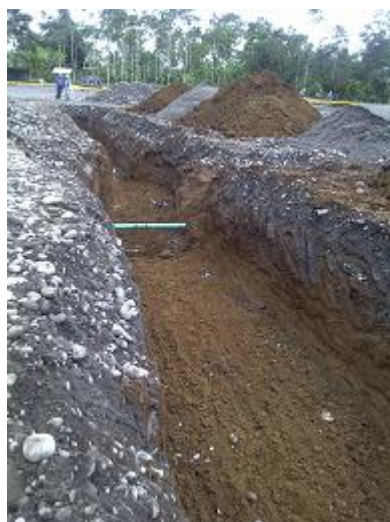
Foto 6.27. Colocación de material a 1.2 m de la zanja.
