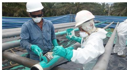
Foto 4.5. Aplicación de resina epoxica Scotchkote Fuente: Egdo. Paul Álvarez
