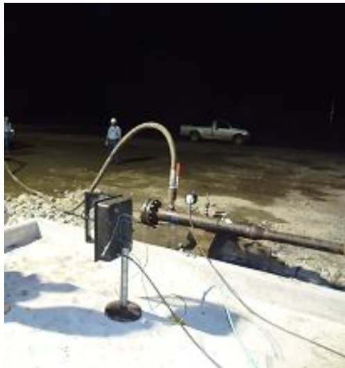
Foto 6.37. Cabezal de pruebas hidrostáticas con instrumentación.
