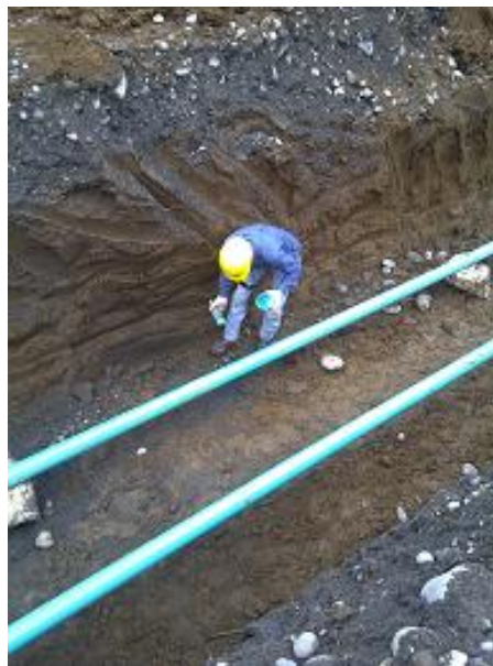
Foto 6.29. Reparación de "Hollidays" en tubería instalada.
