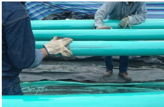
Foto 6.26. Reparación de “Hollidays” en recubrimiento.
