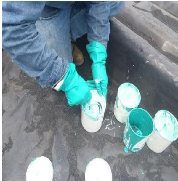
Foto 6.21. Preparación de pintura epóxica.
