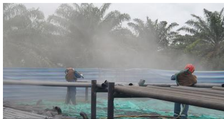
Foto 4.4. Limpieza con chorro abrasivo "granallado" Fuente: Egdo. Paul Álvarez
