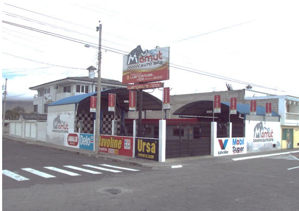
Fuente: Fachada principal - Empresa Mamut Auto Spa
