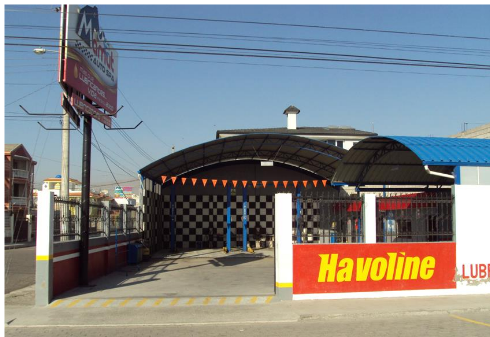
Fuente: Fachada principal - Empresa Mamut Auto Spa
