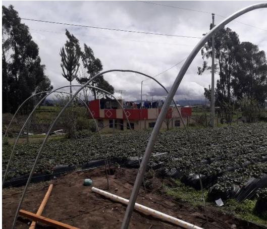
Figura D2: Ubicación e instalación de la estructura del invernadero hidropónico. Elaborado por: el investigador
