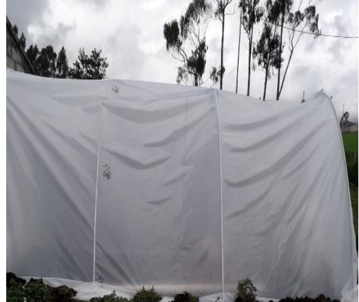
Figura D3: Instalación de la cubierta del invernadero Elaborado por: el investigador
