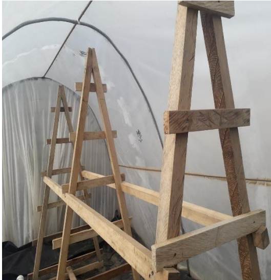
Figura D5. Construcción de soporte de madera para tubería PVC del sistema NFT con un ángulo de inclinación de 76 grados.
