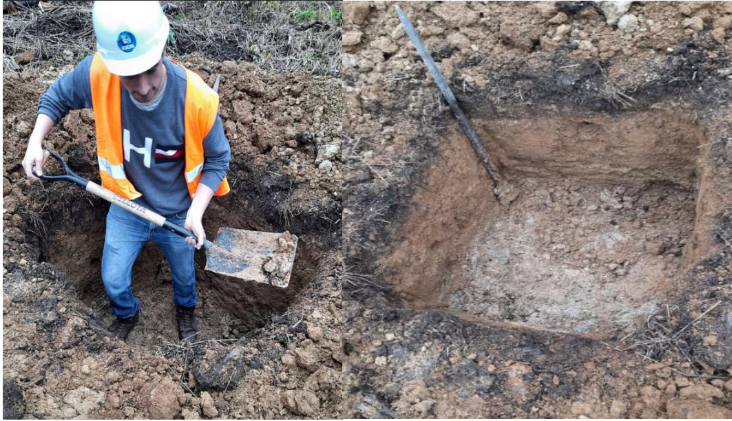
Fig. 20 Pozo a cielo Abierto Realizado: R. D. Villacrés Chérrez
