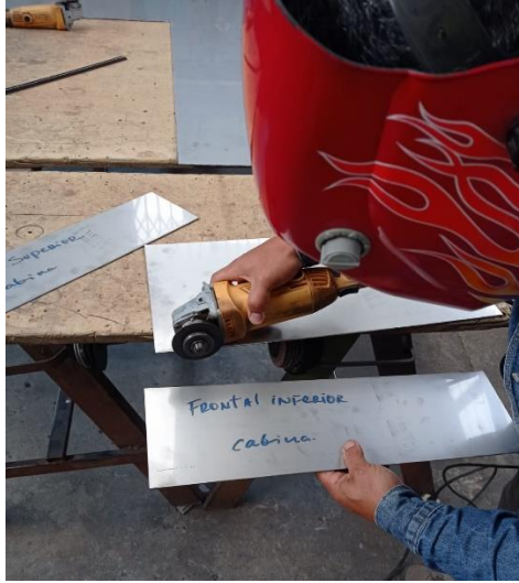
Figura 25 Utilización de las herramientas de corte para la preparación del material
