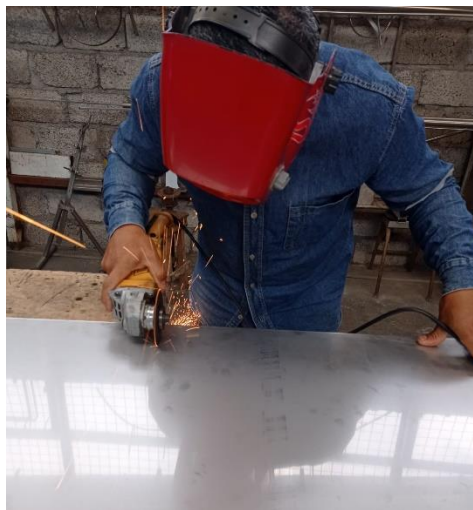
Figura 24 Utilización de las herramientas de corte para la preparación del material
