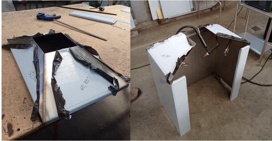
Figura 29 Armado de la campana y unión al cuerpo de la cámara de combustión
