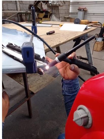
Figura 28 Proceso de soldadura TIG aplicado en el ensamblaje de la campana de la cámara de combustión
