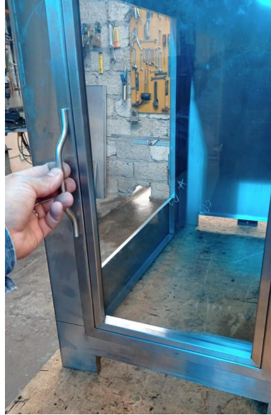
Figura 31 Colocación de las puertas en la cámara de combustión
