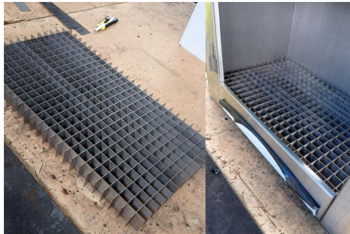
Figura 32 Ensamblaje y colocación de la malla de acero
