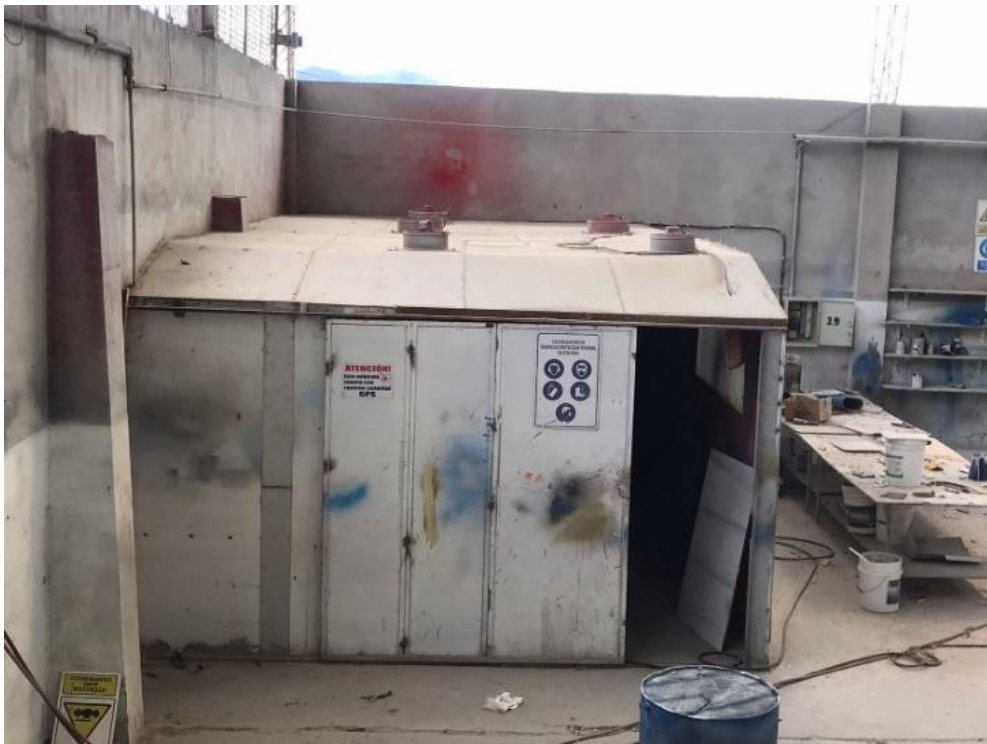
Figura 19: Cuarto de secado de la empresa VARMA S.A.
