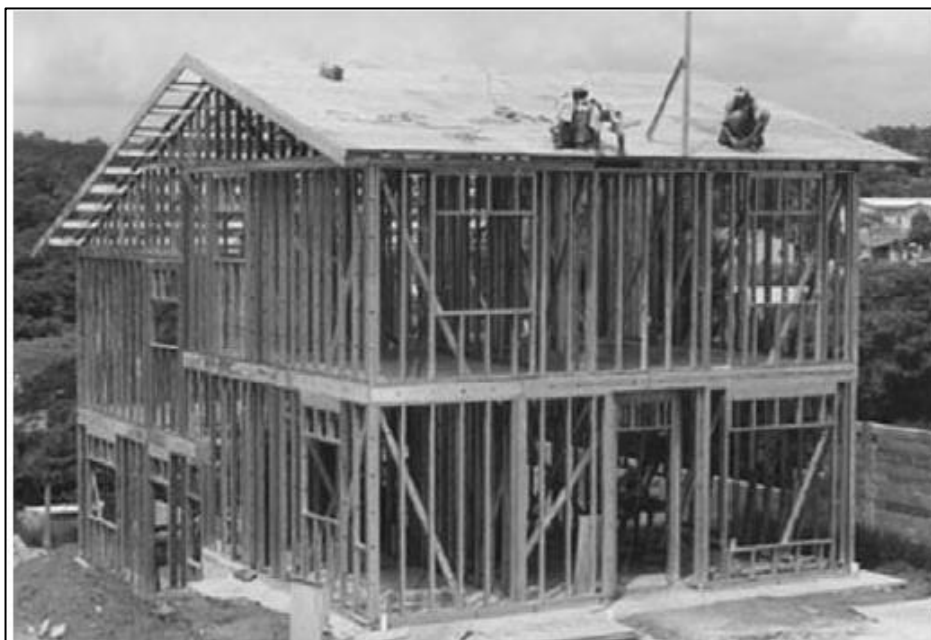
Figura 2-1: Estructura de una vivienda en Steel Framing.[1]
