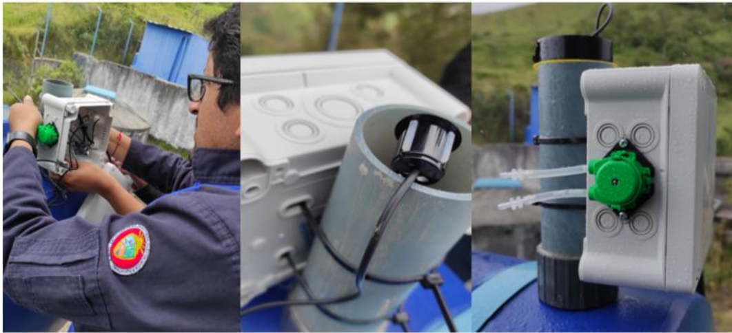
Figura 36. Instalación de la bomba peristáltica y del sensor impermeable
