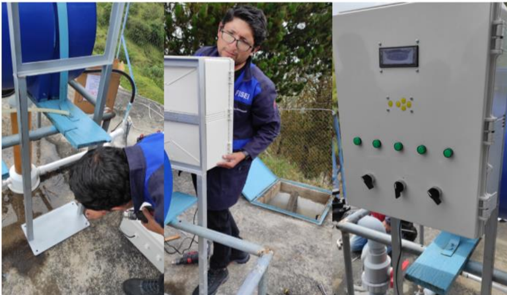
Figura 34. Instalación del gabinete metálico
