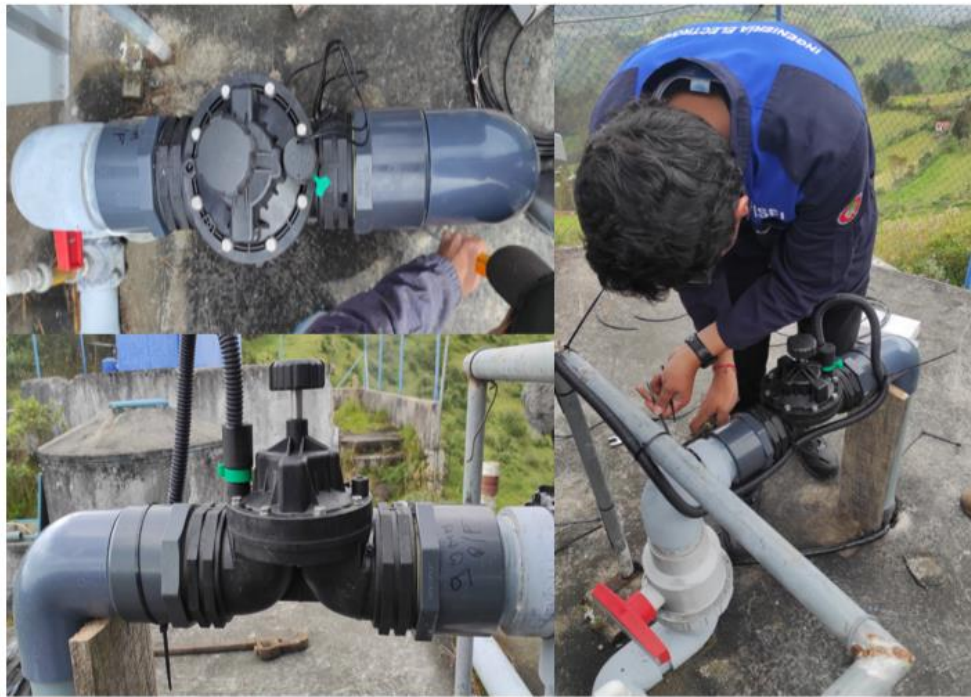
Figura 35. Instalación de la electroválvula
