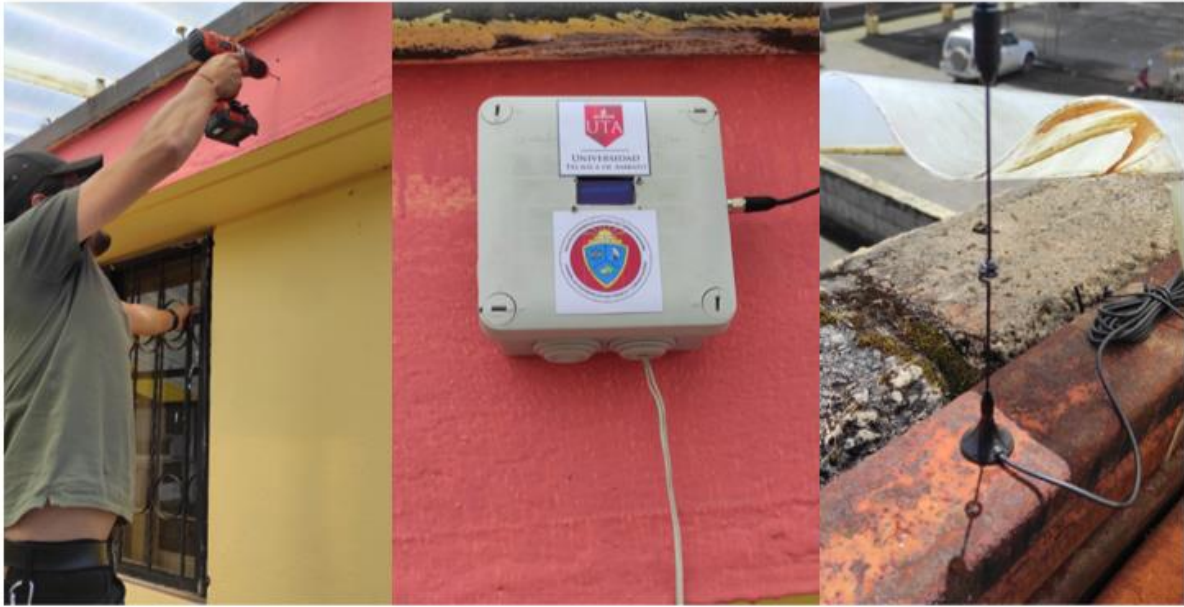
Figura 41. Instalación del nodo receptor
