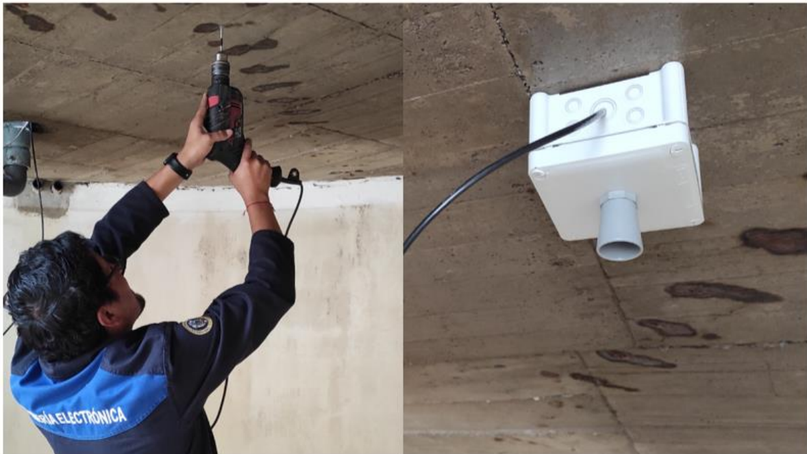
Figura 38. Instalación del sensor ultrasónico industrial
