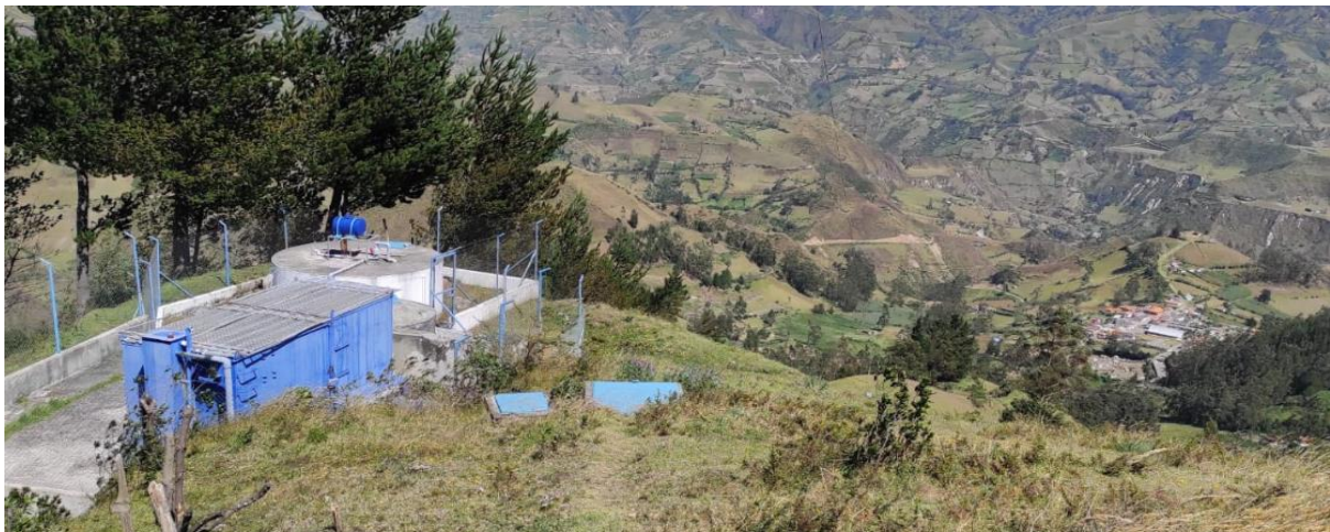
Figura 32. Visualización del tanque de agua con el pueblo de Isinliví
