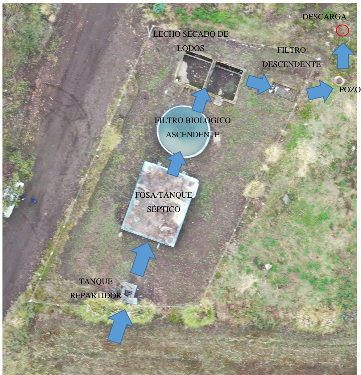
Figura 16. Estado actual de la PTAR Rumipamba y su funcionamiento Fuente: El autor Andrea Villacis – Ing. Lenin Silva
