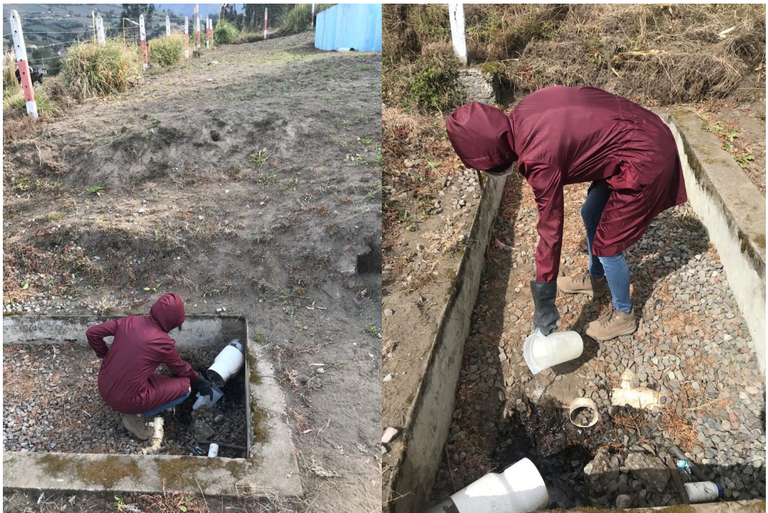
Figura 13. Toma de caudales de salida de la PTAR Fuente: El autor Andrea Villacis
