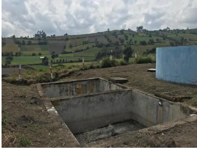
Figura 20. Lecho de secado de lodos PTAR Rumipamba Fuente: El autor Andrea Villacis
