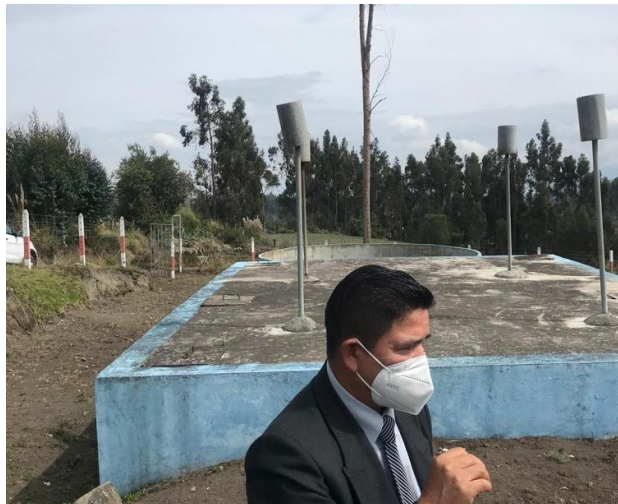
Figura 18. Fosa séptica PTAR Rumipamba Fuente: El autor Andrea Villacis
