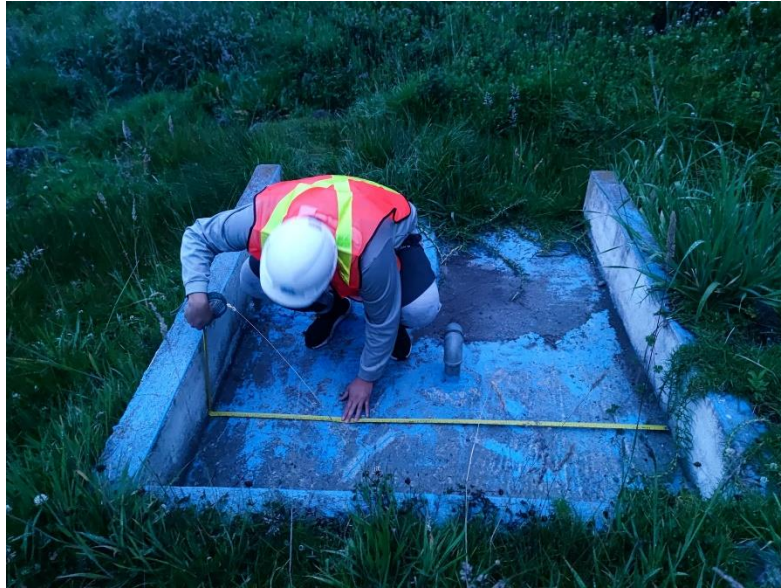
3.Medición del tanque
