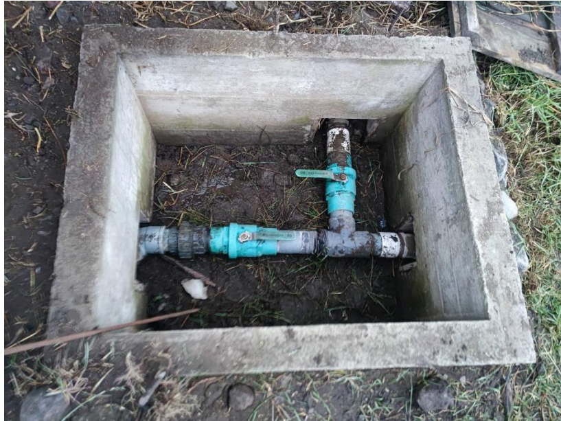
5. Válvula de desfogue sin tapa, cualquiera puede manipularlo
