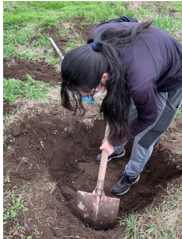
Figura 108. Excavación de calicata
