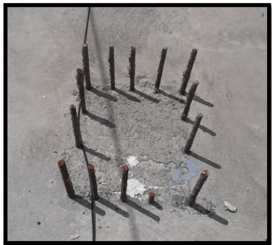
Verificación del acero de refuerzo de elementos estructurales.
