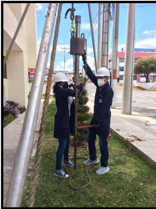
Proceso del Ensayo SPT
