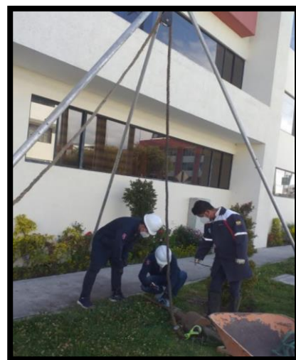
Implantación del Equipo para el Ensayo SPT.
