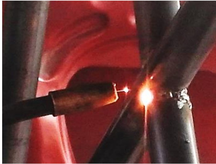
Figura 116. Proceso de soldadura en las uniones de los elementos de la estructura de seguridad.
