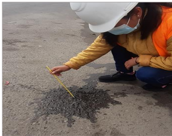
Gráfico 3. 64. Registro de Temperatura en la calzada.
